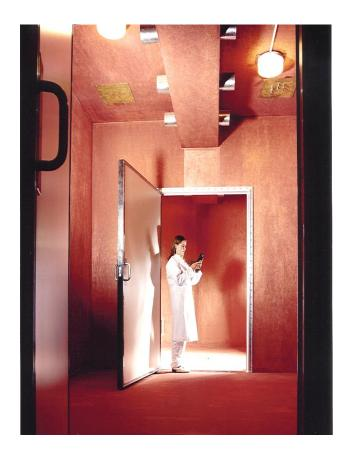
Bei der Kupfervlies-Bauweise erreicht man eine Abschirm-Dämpfung von ca. 60 - 70 dB im Frequenzbereich von 10 MHz bis 10 GHz.
